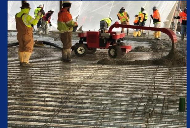
2<sup>nd</sup> level west elevated slab pour in progress
